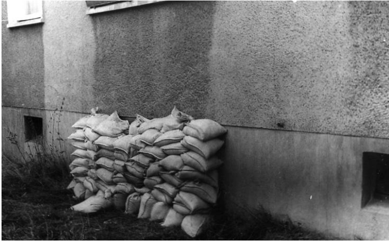
Abb. 5: Das Kellerfenster wurde durch Sandsäcke gesichert damit keine radioaktive Strahlung eindringen kann. Einer Druckwelle hätten die Sandsäcke sicherlich nicht Stand gehalten.
