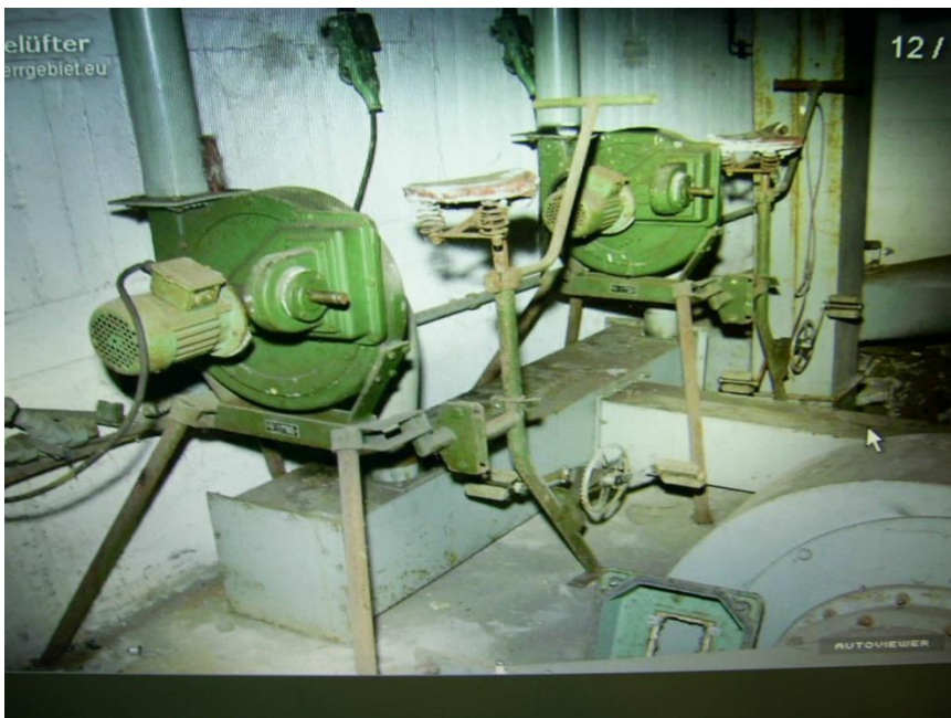
Abb. 18: Elektrische Bunkerlüftung zum Verkauf bei Ebay. So muss man sich die Lüftungen vorstellen
