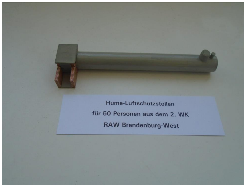
Abb. 3: Beispiel für ein Altbauwerk aus dem zweiten Weltkrieg, ein sogenannter Hume-Luftschutzstollen. Da es in der Realität nur Fotos vom Eingangsbauwerk und die Konstruktionszeichnungen gibt, verdeutlicht das Modell den Aufbau. Eingangsbauwerk, Stahlröhre aus Stahlsegmenten, Notausstieg und Lüftung.
