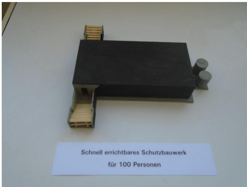
Abb. 14: Dieses Bauwerk ist bereits mit Asphalt für den Nässeschutz vergossen. Die Zylinder rechts sind Kanalringe die zu Lüftungen umfunktioniert wurden. Die Verbindung zwischen Bauwerk und Lüftungen sind einfache Rohre.
