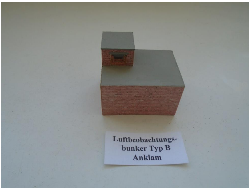
Abb. 2: Luftbeobachtungsbunker Typ B in Ziegelbauweise. Obwohl es sich um ein Typenbau handelte war die Ausführung sehr unterschiedlich: Ziegel rot oder weiß, verputzt etc. Dieser Typ weist eine Beobachtungskanzel auf in der ein Beobachter saß.
