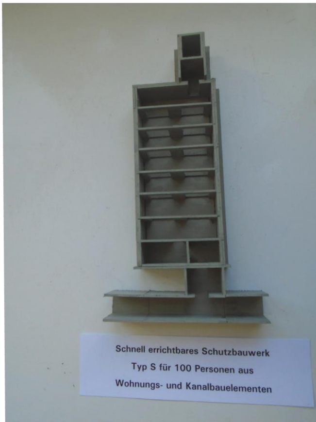
Abb. 12: Dieses Schutzbauwerk für 100 Personen zeigt ein von beiden Seiten zugängliches Eingangsbauwerk noch ohne Treppen. Es folgt die Schleuse und der eigentliche Bunkerraum. Dieser besteht aus doppelten versetzt eingebauten Betonplatten. Der Anbau oben im Bild ist aus Kanalbauelementen gefertigt und dient als Lüftung sowie als Notausstieg.
