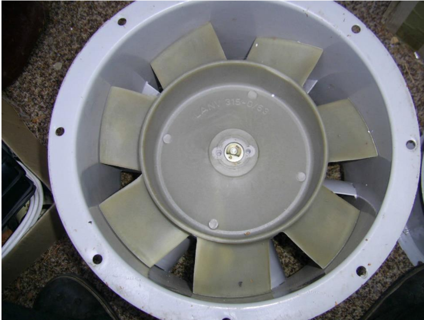
Abb. 4: Lüfter aus einem Schutzbauwerk 300
