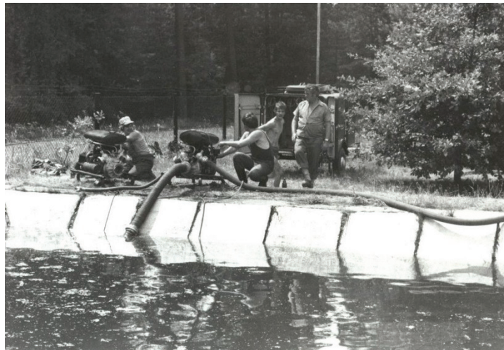
Abb. 5: Auf dieser Aufnahme ist der Tragkraftspritzenanhänger zu erkennen. Baugleich war der Schlauchtransportanhänger
