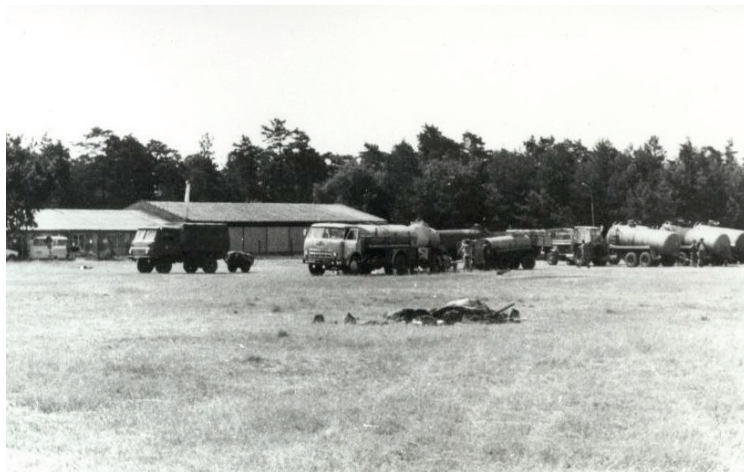
Abb. 8: Einsatzübung auf einem Feldflugplatz zum Betanken von Agrarflugzeugen die als Löschflugzeuge eingesetzt wurden. Wieder sind die Güllewagen und Traktoren als Zugmittel erkennbar. Links im Bild ist ein Robur LF 8 zu erkennen der einen Pulveranhänger im Schlepp hat. Dieses Fahrzeug gehörte zu einem Depot der NVA und fungierte als Flugplatzfeuerwehr. Der Tankwagen im Mittelgrund ist ein russischer MAZ, beheimatet bei der Agrarflugstaffel
