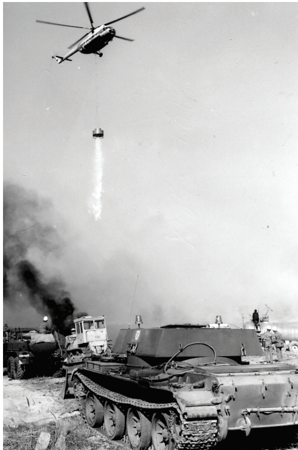
Abb. 9: Räumpanzer T 54 mit Fahrgestell des Flakpanzers ZSU 57-2. Bei dieser Übung wurde der Einsatz von Mi 8-Hubschraubern mit Wasserabwurfbehälter 2.000 Liter erprobt.
