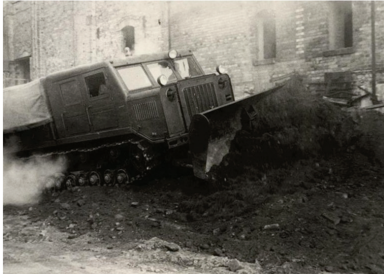
Abb. 5: Kettenzugmaschine AT-S mit Räämschaufel bei der Arbeit. Für die damalige Zeit war die AT-S mit ihren 250 PS ein Kraftprotz
