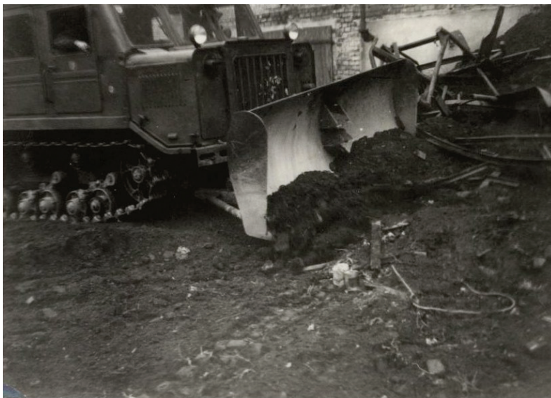
Abb. 6: Detailansicht der Räämschaufel
